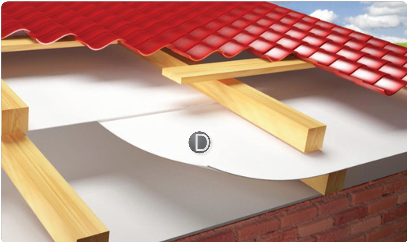
«Мегаспан D» дополнительно закрепляем строительным степлером к стропилам. Нижняя кромка мембранны должна обеспечивать естественное стекание излишней влаги (если таковая появилась) с мембранны в водосточную систему. Поверх мембранны к стропилам саморезами крепим контррейки. По контррейкам монтируем обрешётку, на которую впоследствии укладываем кровельное покрытие. Места крепления мембранны к стропилам мы рекомендуем проклеивать самоклеящейся уплотнительной лентой.
