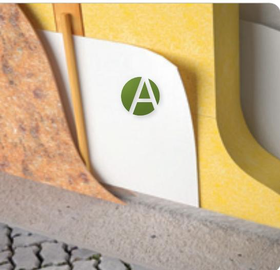
Мембрану «Мегаспан А» дополнительно закрепляем строительным степлером к деревянному каркасу. Поверх мембранны к стропилам саморезами монтируем контррейки размером 4\*5 см. По контррейкам монтируем внешнюю отделку (сайдинг и т.д.).
